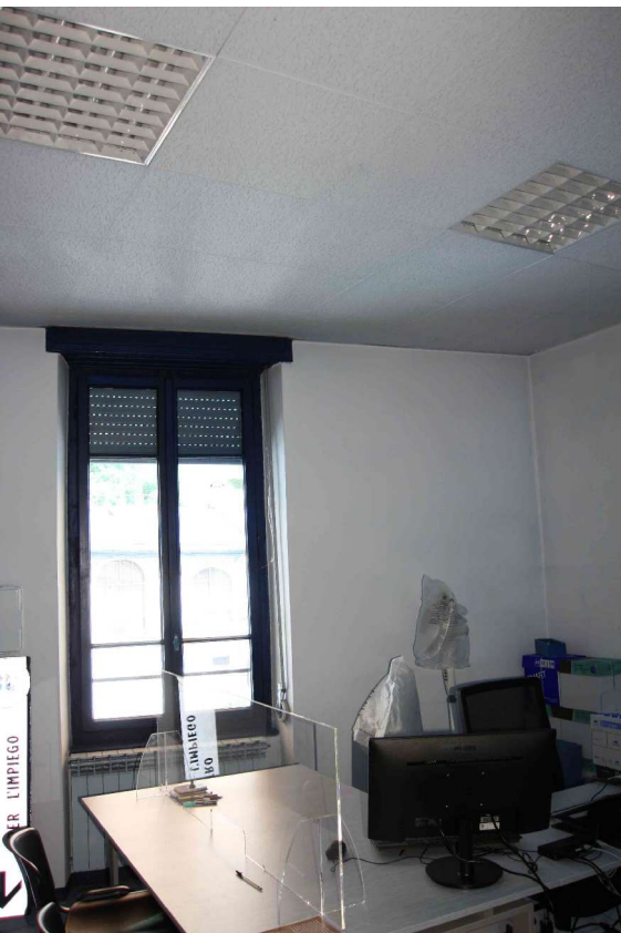
FOTOGRAFIA 03: PARTICOLARE CONTROSOFFITO IN PANNELLI DI GESSO
